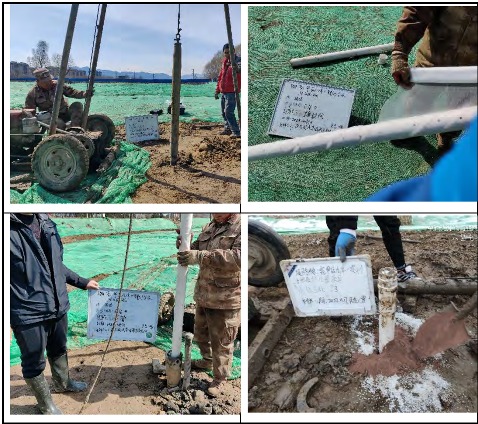
图 4-6 地下水监测井施工照片
