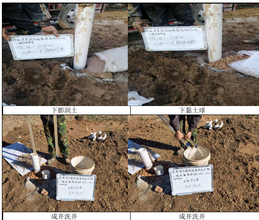
图 4.4-4 地下水监测井施工照片
