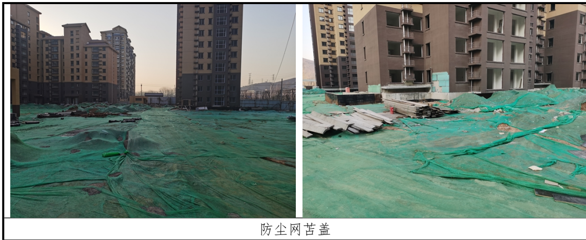
图 3-4 施工现场临时措施实施情况照片
