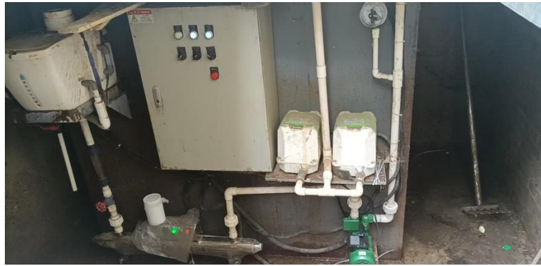
图 3-2 本项目一体化污水处理设备现状照片
