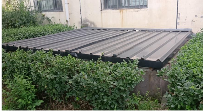
图 3-1 本项目一体化污水处理设备现状照片
