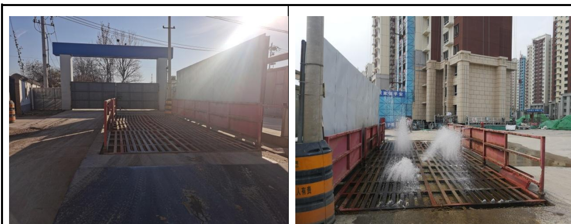
车辆清洗槽（配套沉沙池）
