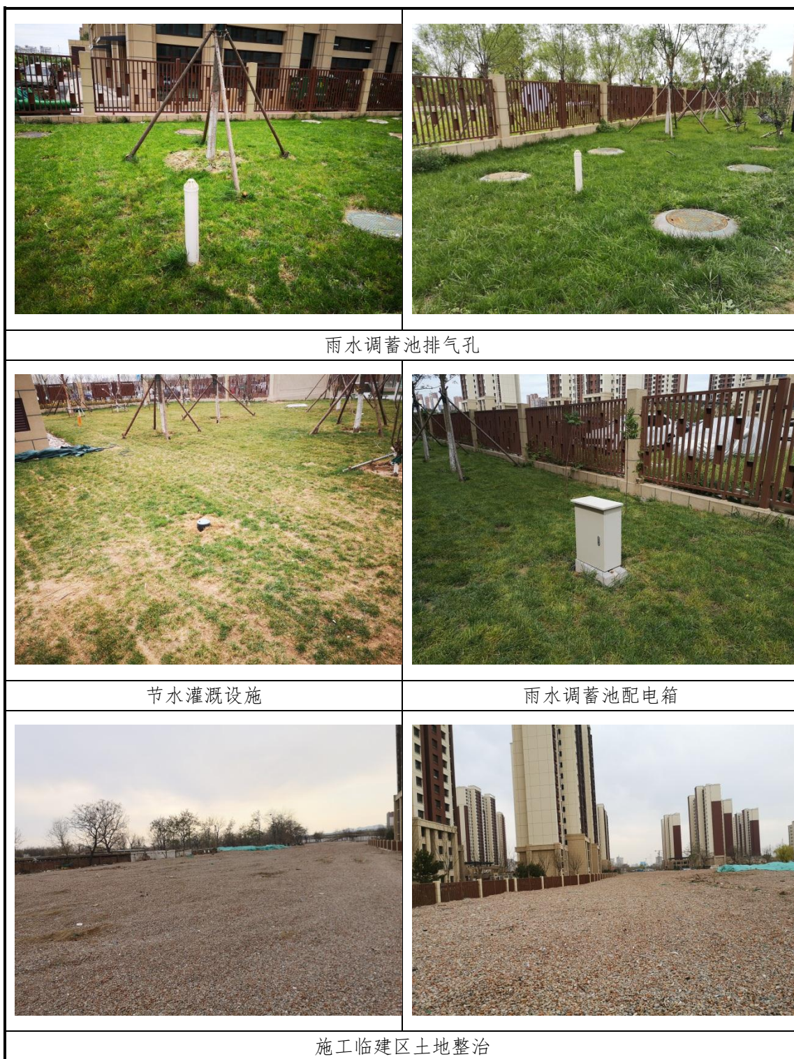
图 3-1 工程措施实施照片
