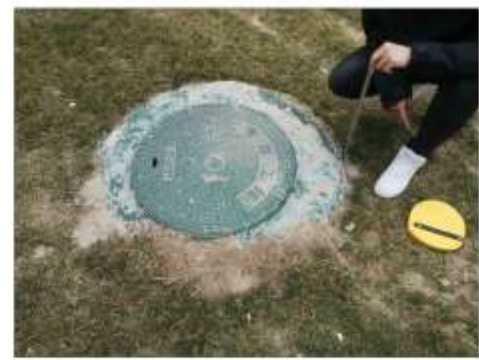
雨水调蓄池检查井
