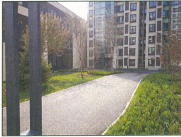
透水混凝土铺装
