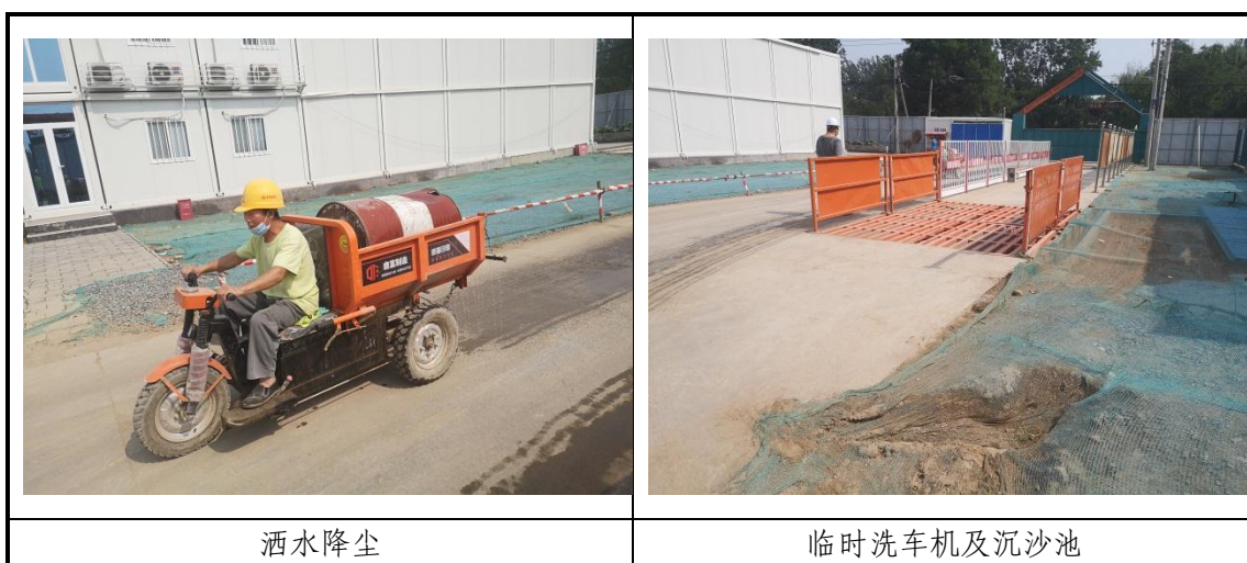
图 3-3 施工现场临时措施实施情况照片
