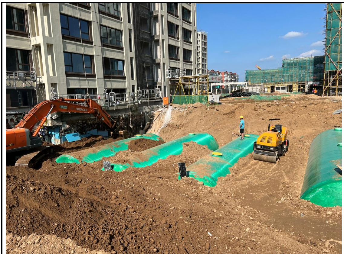
雨水调蓄池及化粪池施工 (2022年7月29日)
