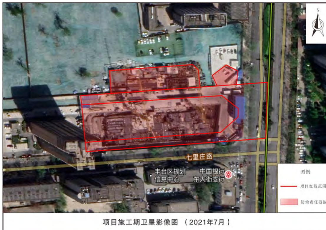
图 5-3 项目施工期影像图（2）
