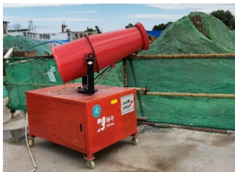
图 2-8 洒水降尘措施 (2022.8)
