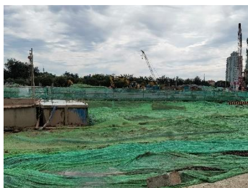
图 2-4 裸露面苫盖措施 (2022.8)
