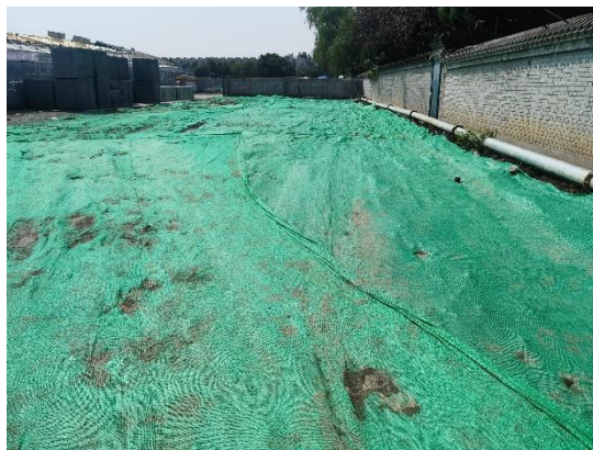
图 3-8 施工生活区苫盖情况 (2023.8.4)
