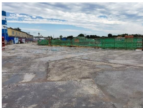
图 2-3 场地施工道路硬化 (2022.8)
