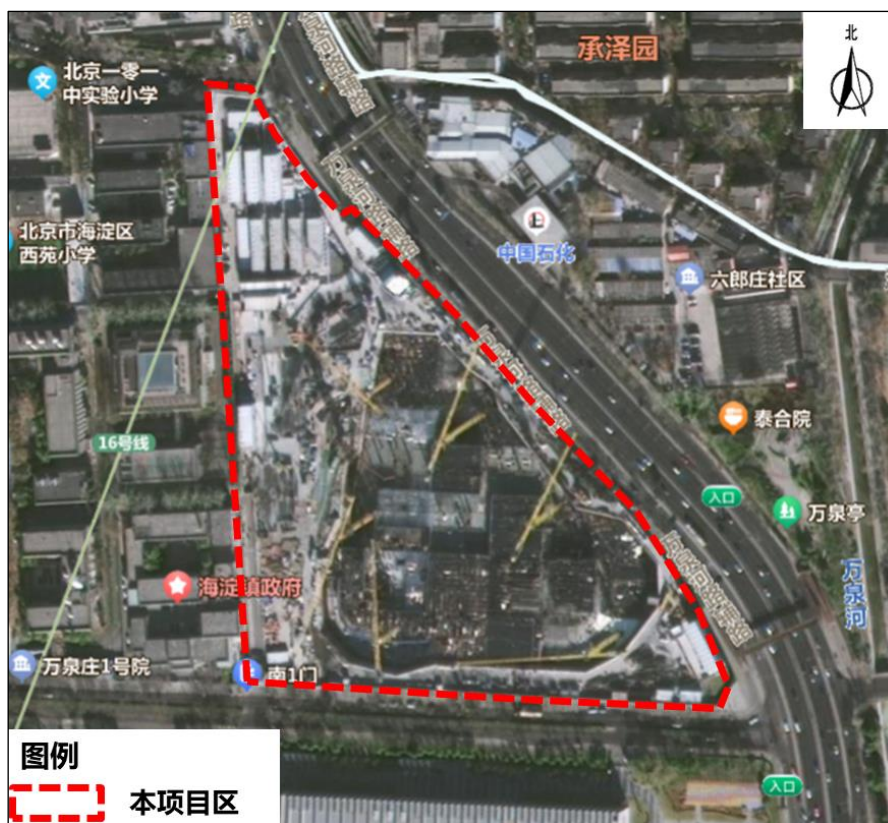
图 3-2 2023 年 8 月建筑结构施工影像图
