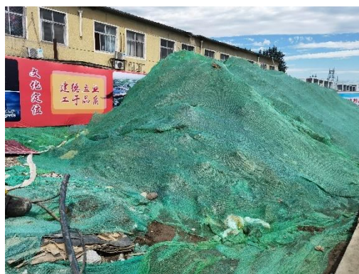
图 2-2 建筑垃圾苫盖措施 (2022.8)
