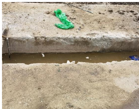
图 2-6 临时排水措施 (2022.8)
