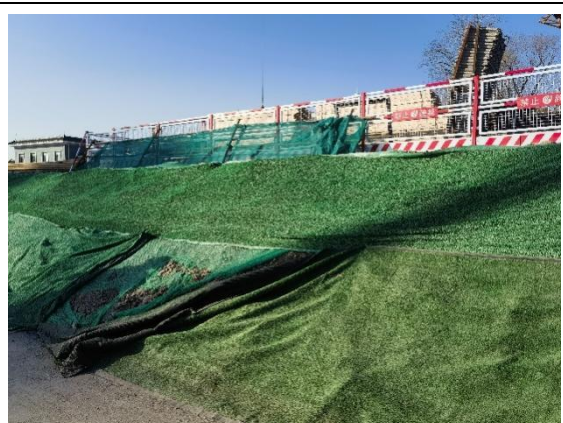
图 2-15 临时堆土现状 (2022 年 12 月)
