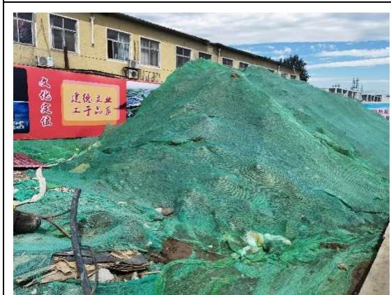
图 2-14 临时堆土现状 (2022 年 12 月)
