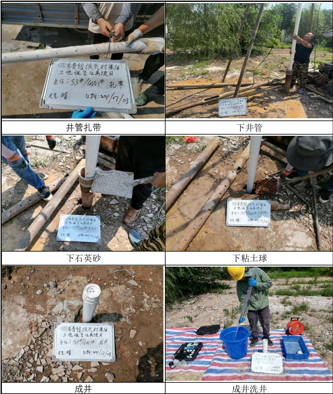
图 4.4-7 地下水监测井施工照片
