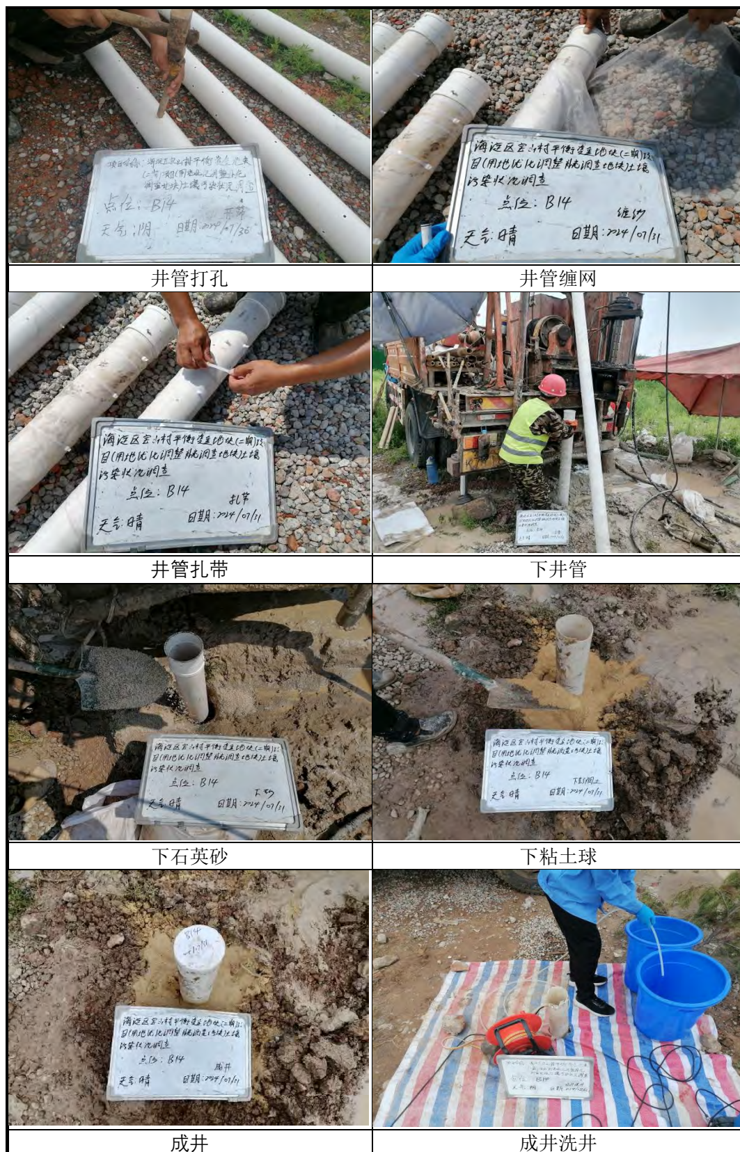
图 4.4-4 地下水监测井施工照片
