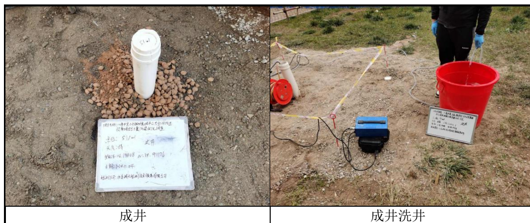
图 4-6 地下水监测井施工照片
