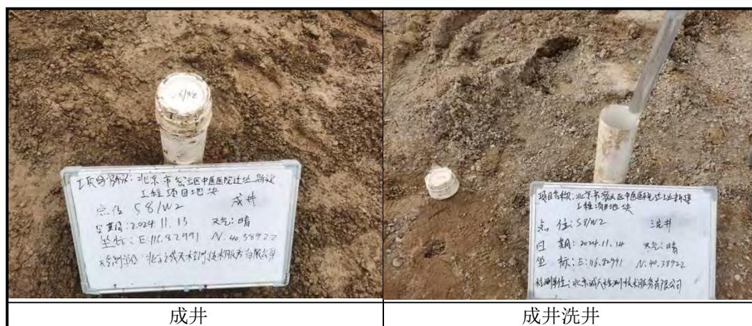
图 4.4-7 地下水监测井施工照片
