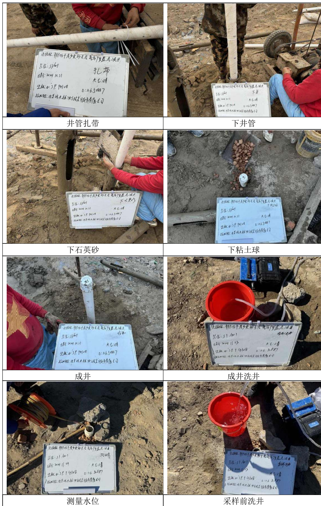
图 4.4-6 地下水监测井施工照片
