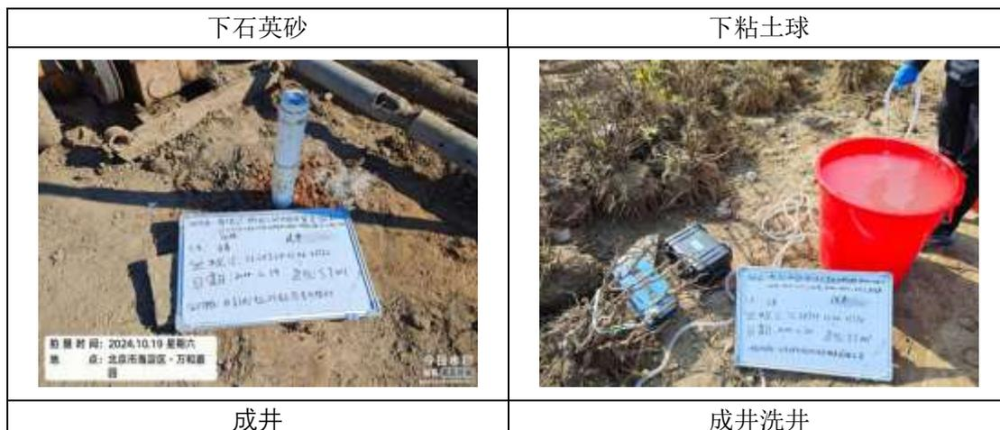
图 4.4-4 地下水监测井施工照片
