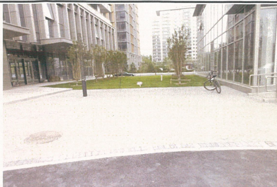
6031 地块透水砖铺装
