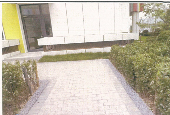
6033 地块透水砖铺装
