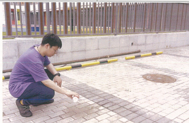
6032 地块透水砖铺装
