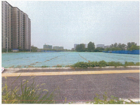
施工办公区土地整治
