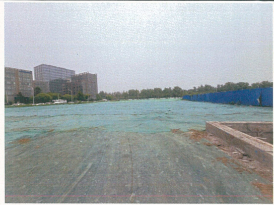
施工生活区土地整治
