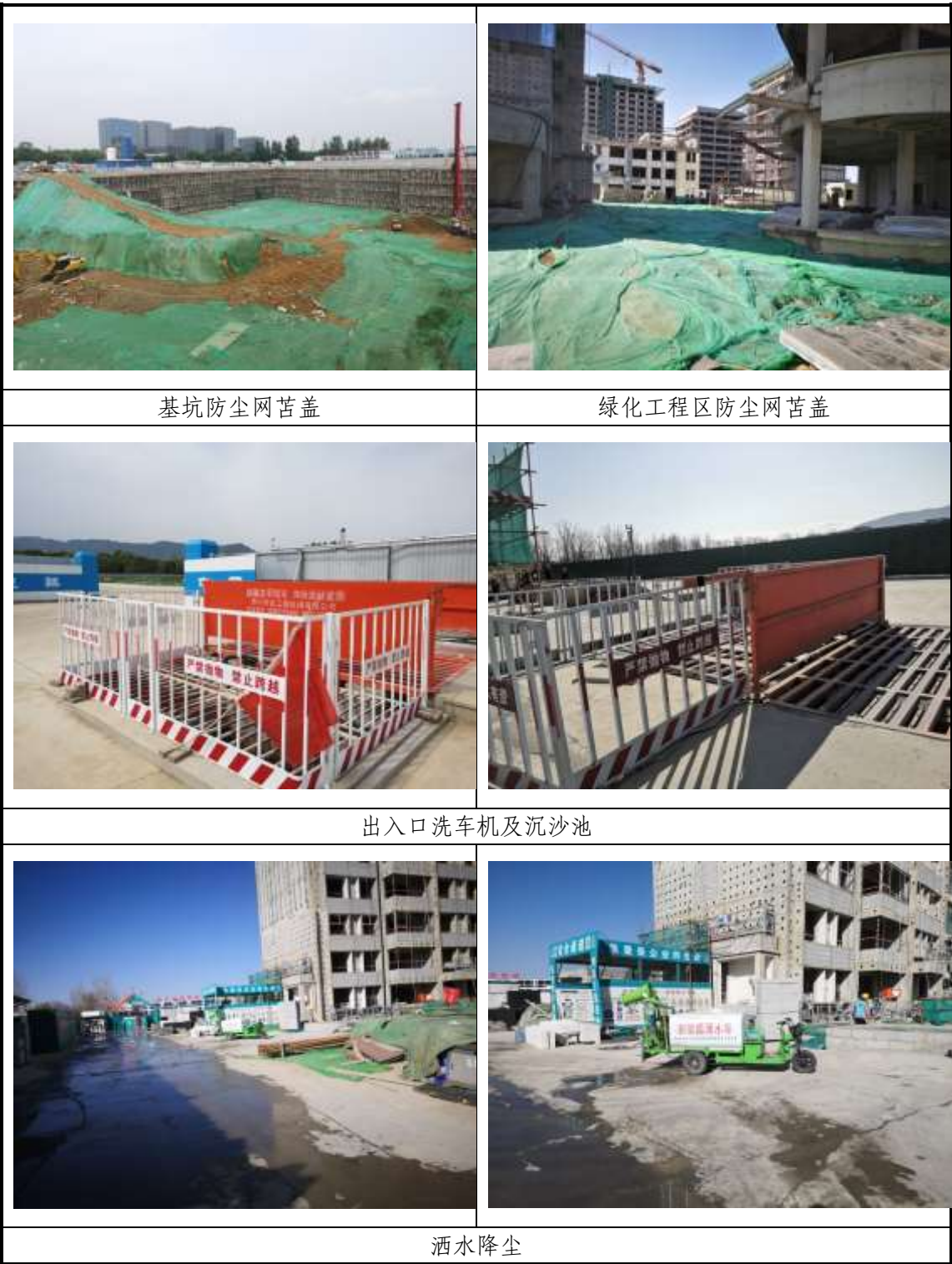
图 3-4 施工现场临时措施实施情况照片
