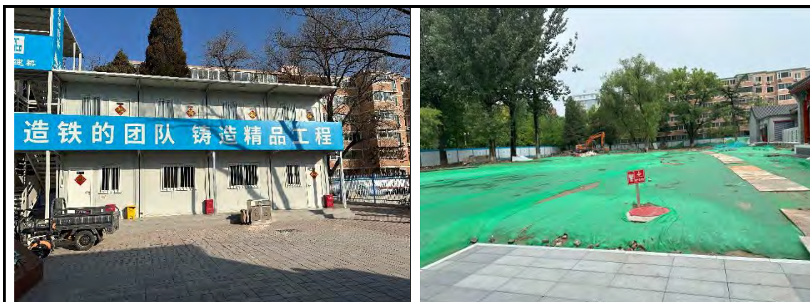
施工临建区（防尘网苫盖、土地整治）
