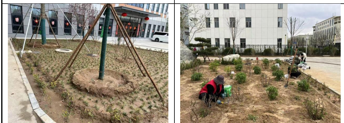
景观绿化施工
