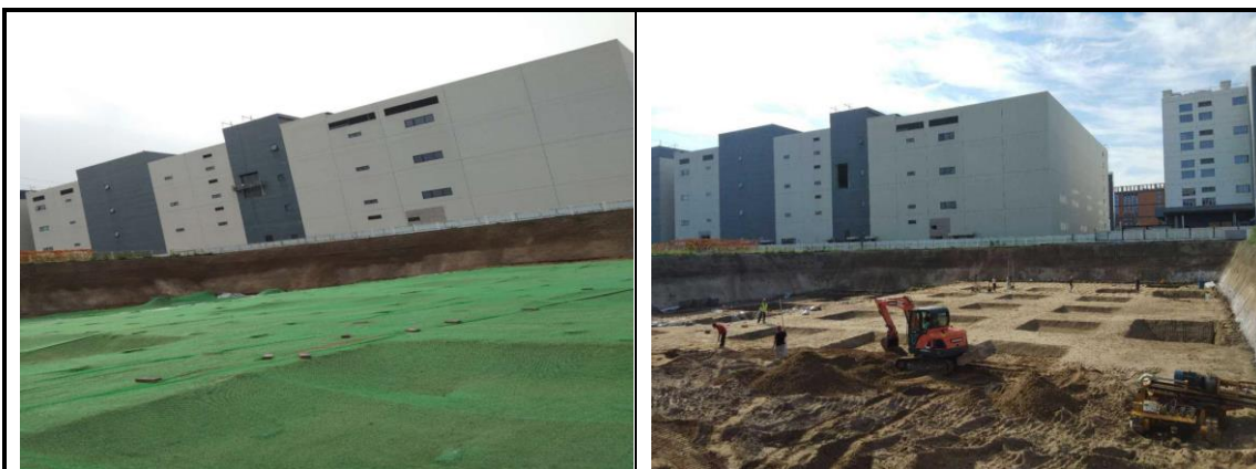
基坑土方开挖施工
