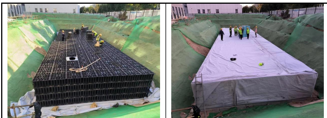
雨水调蓄池施工
