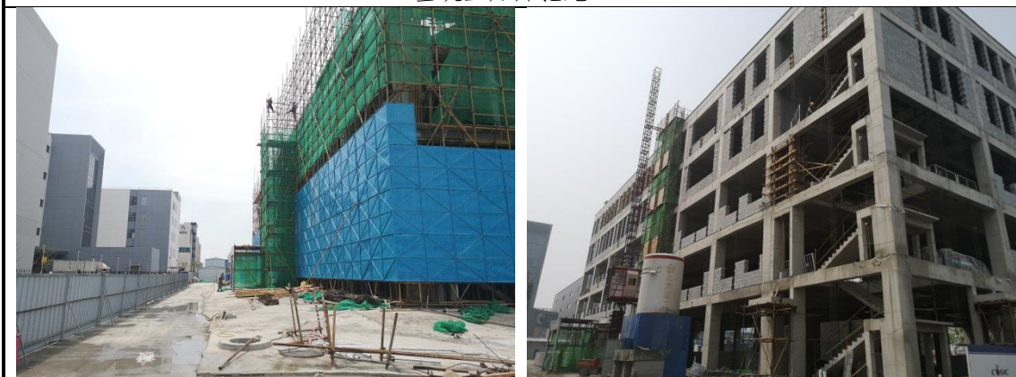
2#实验楼主体施工
