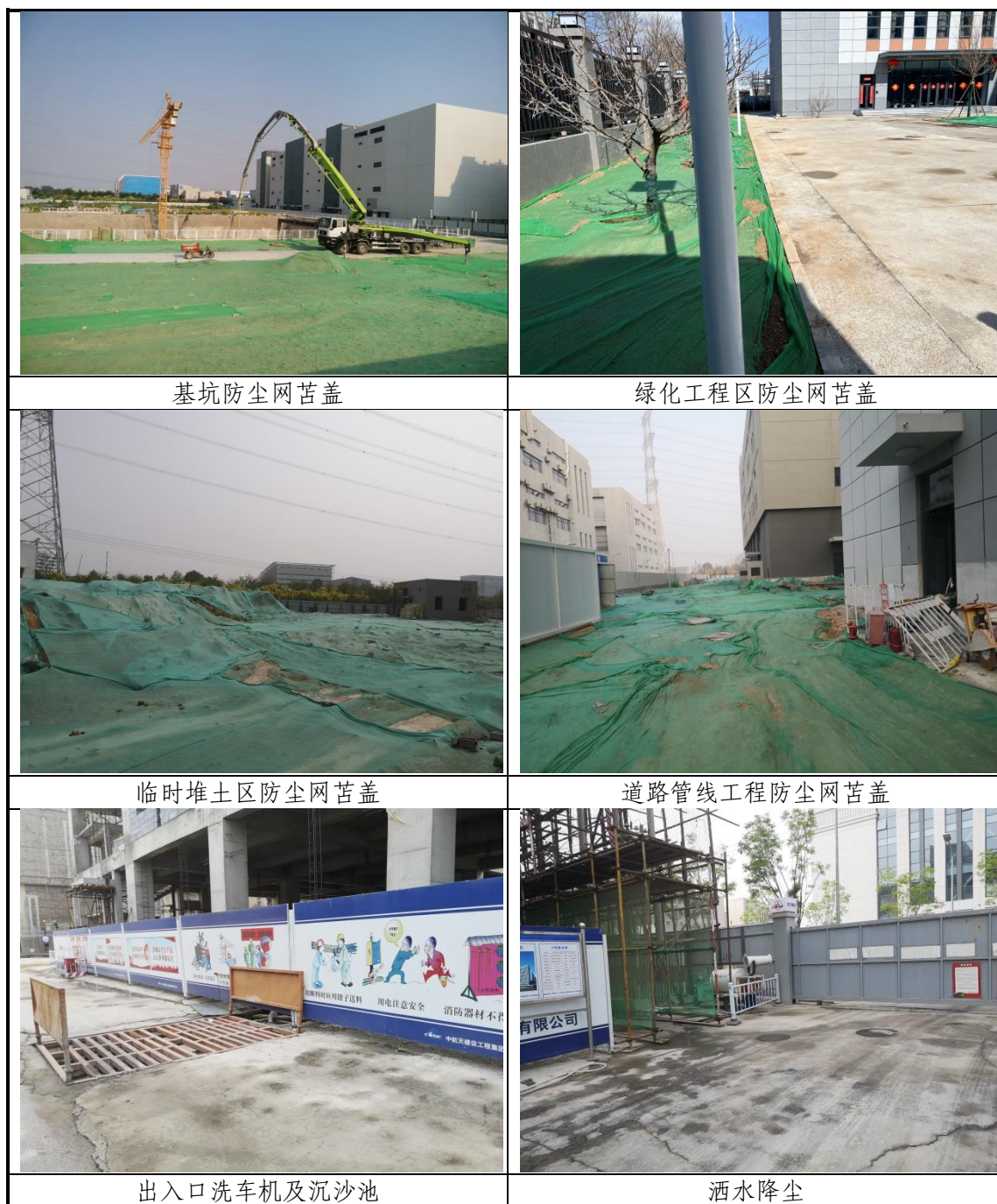
图 4-3 临时防治措施拍摄图
