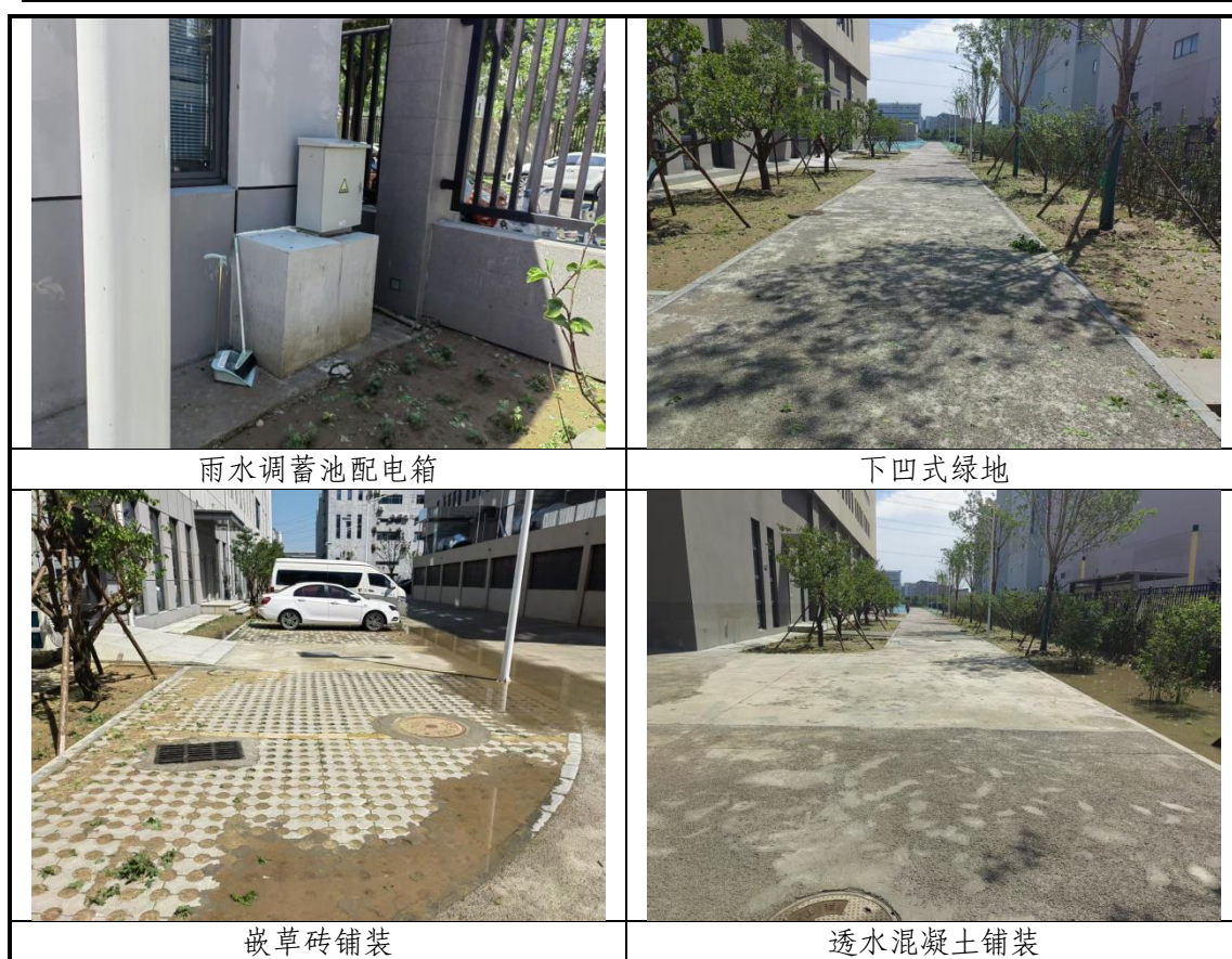
图 4-1 工程措施照片
