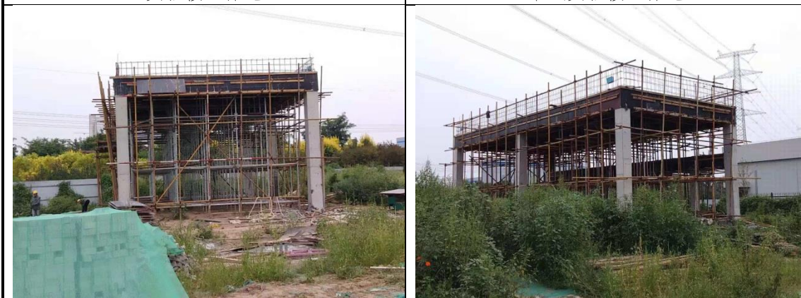
5#污水池结构施工
