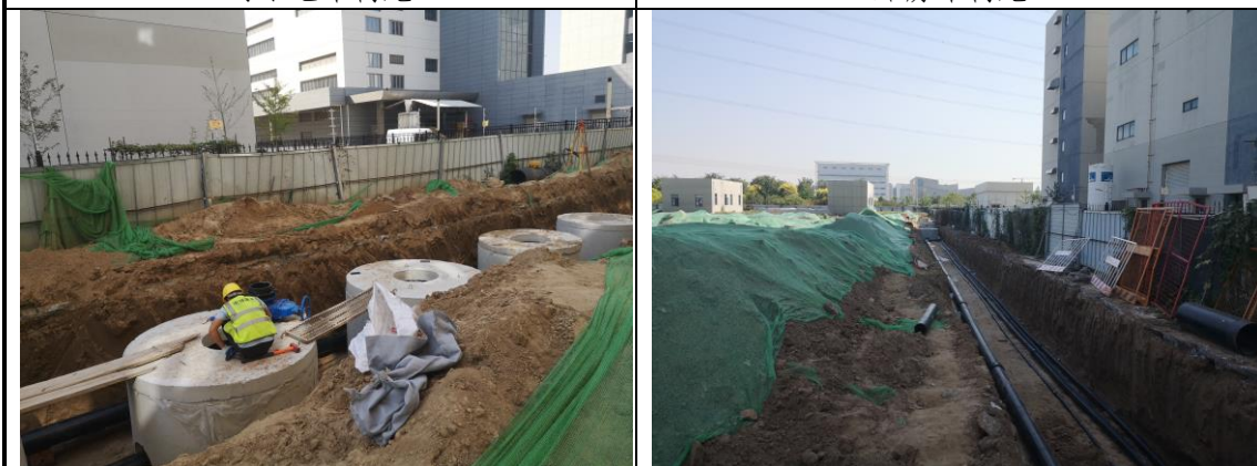
小市政管线工程施工
