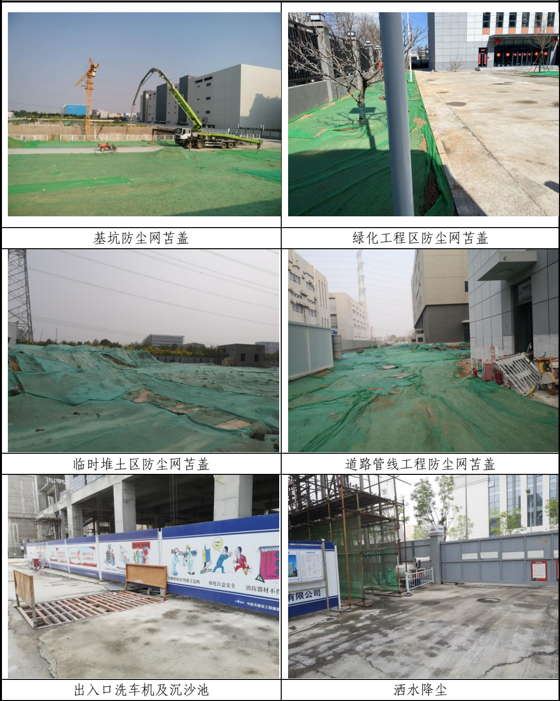
图 3-4 施工现场临时措施实施情况照片
