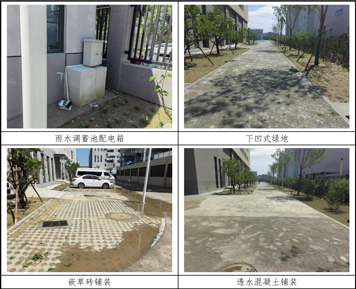
图 3-1 工程措施实施照片
