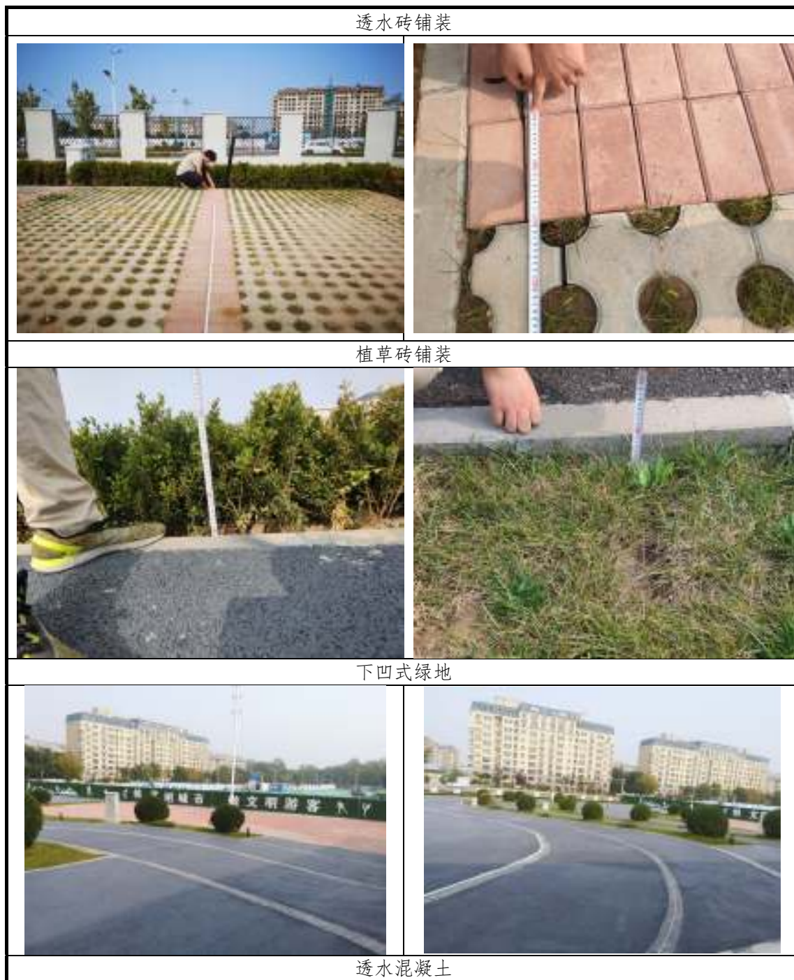
图 4.4-1 水土保持工程措施
