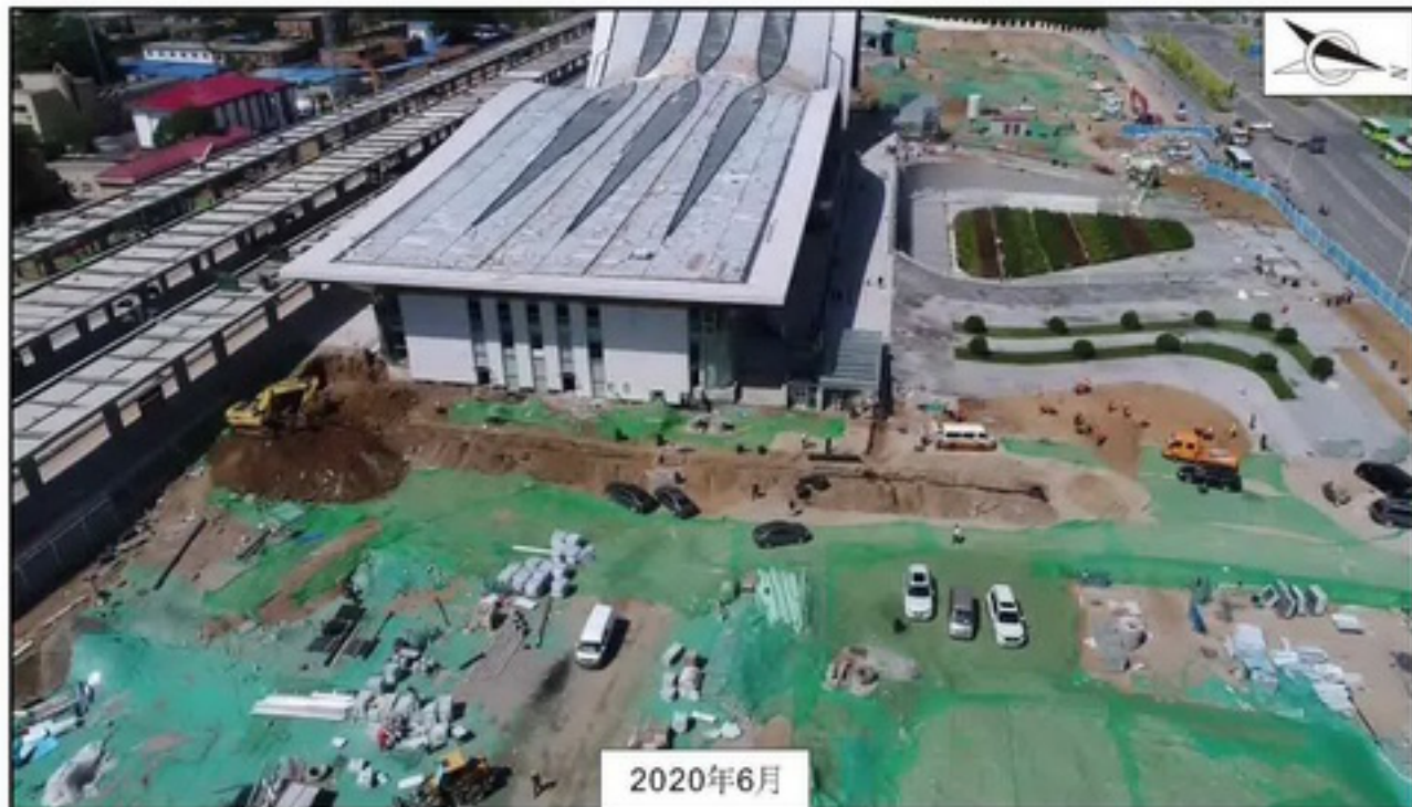
图4-3 项目建设中无人机影像图
