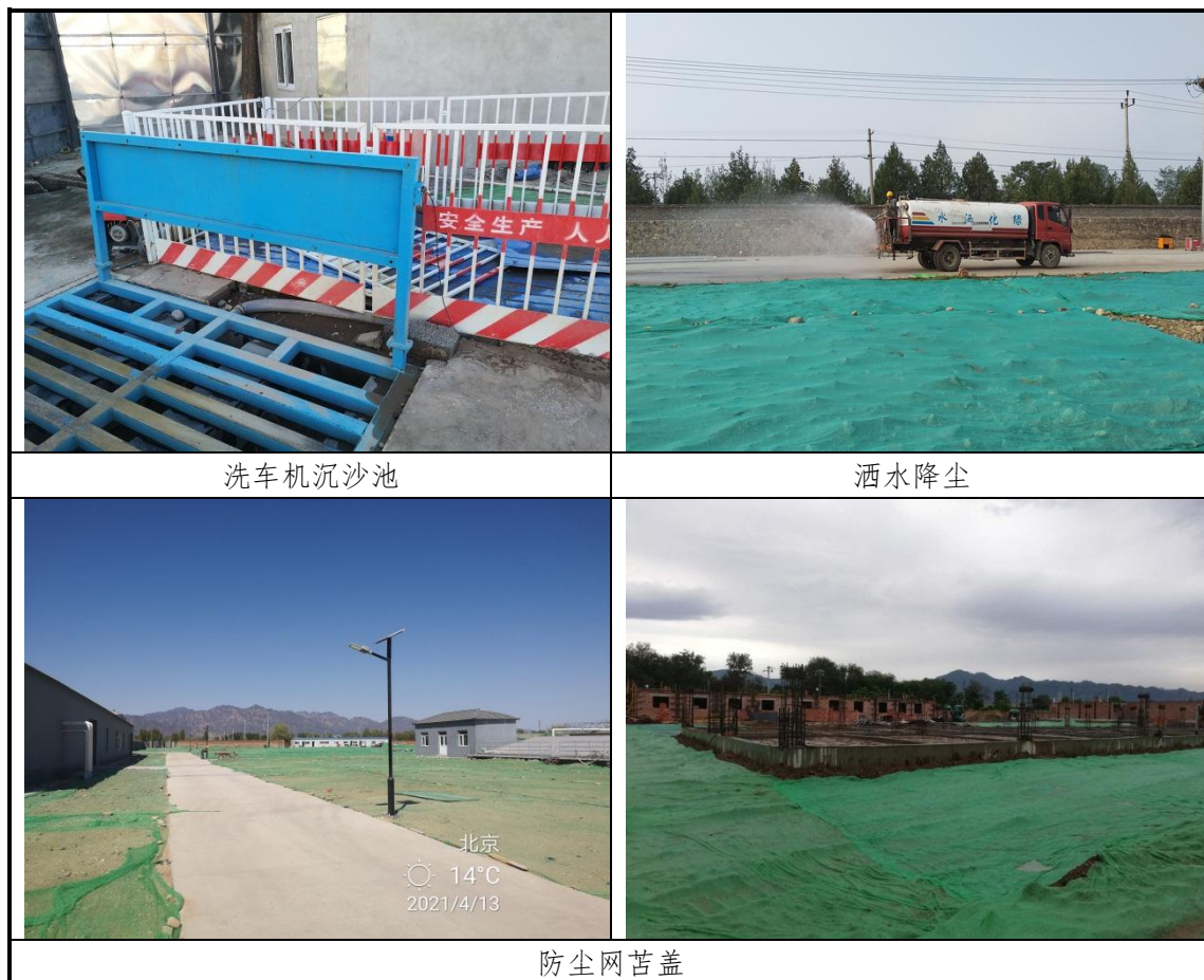
图 3-4 施工现场临时措施实施情况照片
