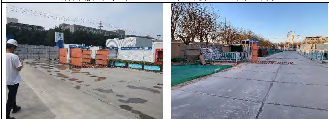
车辆洗车槽及临时沉沙池（2021 年第三季度、2022 年第一季度）
