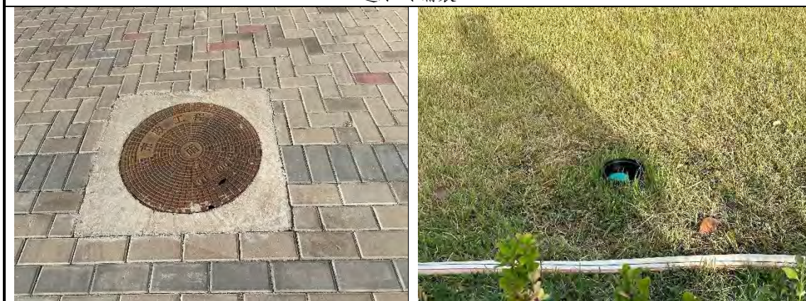
雨水调蓄池检查井
