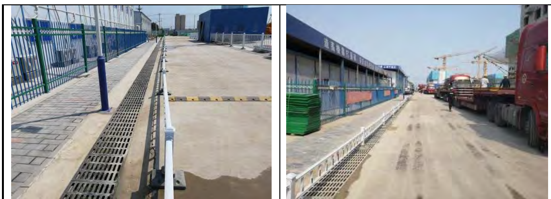
临时排水沟（2020 年第三季度、2021 年第一季度）
