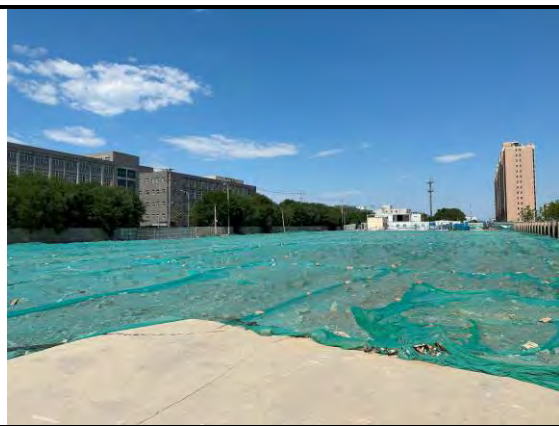
土地平整（施工生产生活区）
