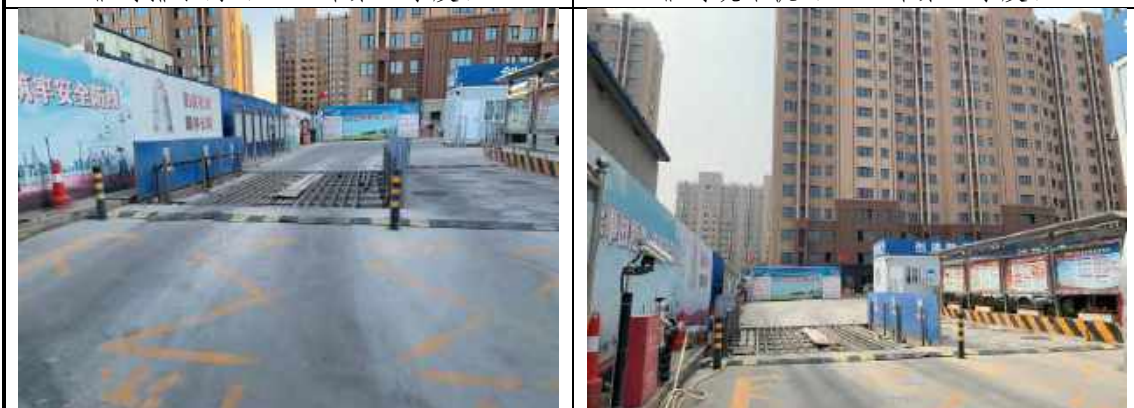
车辆洗车槽及临时沉沙池（2021 年第四季度、2022 年第一季度）
