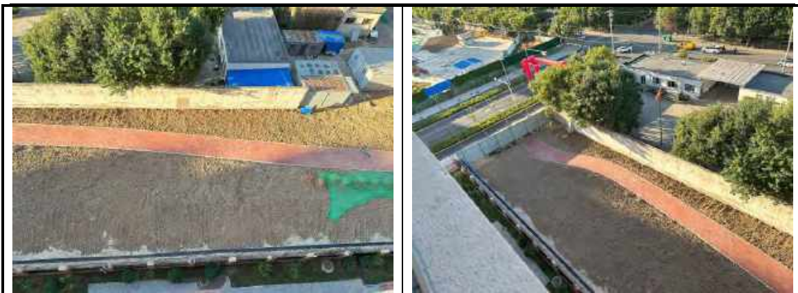
土地平整及后续绿化施工进度
