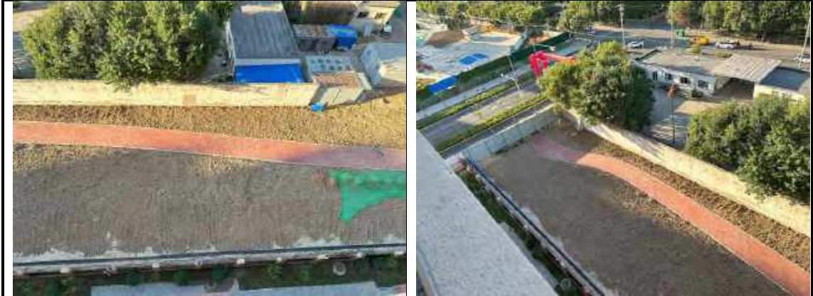
土地平整及后续绿化施工进度（施工生产生活区）
