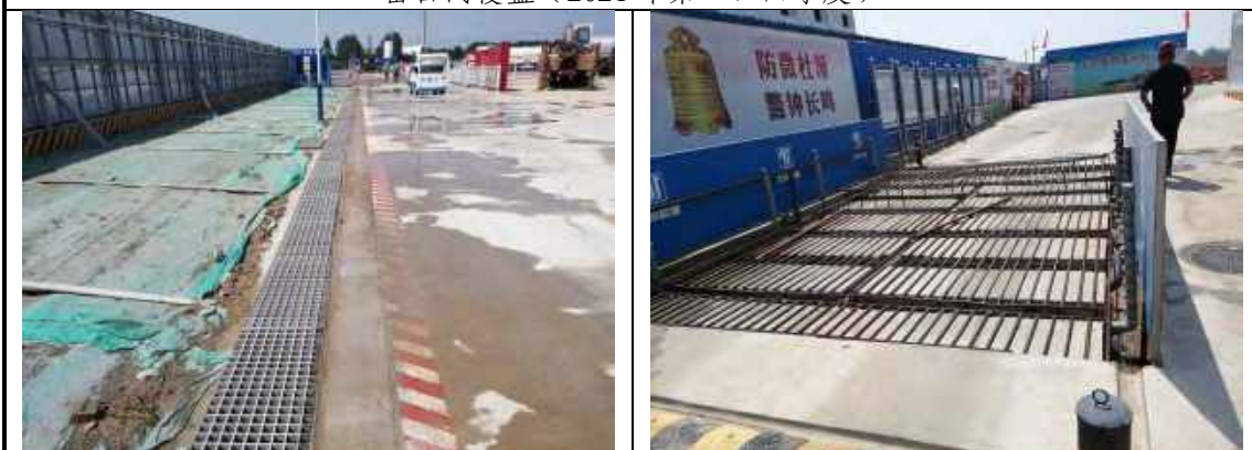
临时排水沟（2020 年第三季度）
