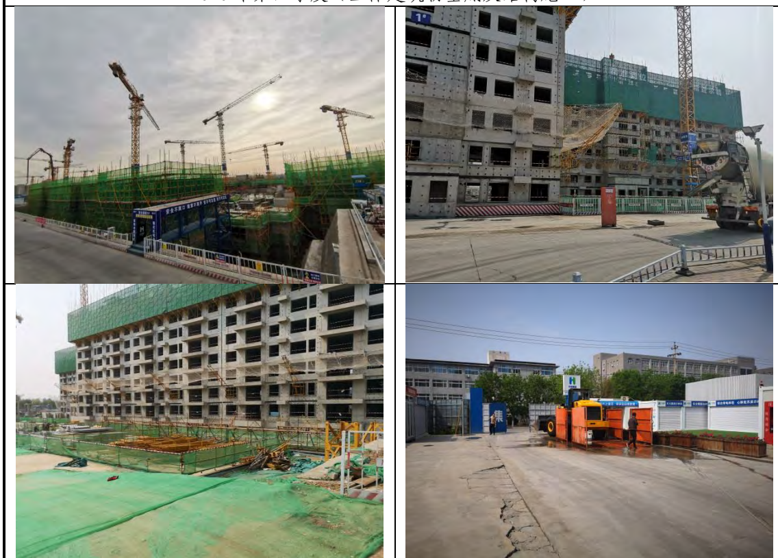
2021 年第一季度（主体建筑物结构施工）
