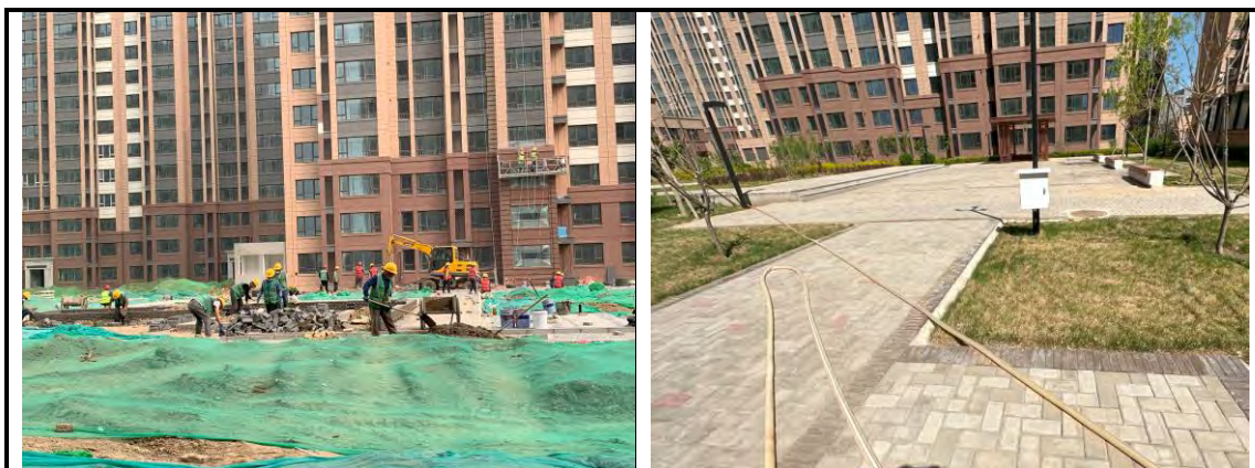
透水砖铺装施工前后
