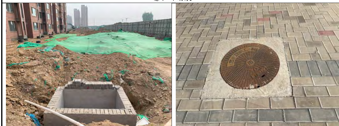
雨水调蓄池施工过程及检查井
