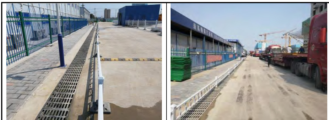
临时排水沟（2020年第三季度、2021年第一季度）
