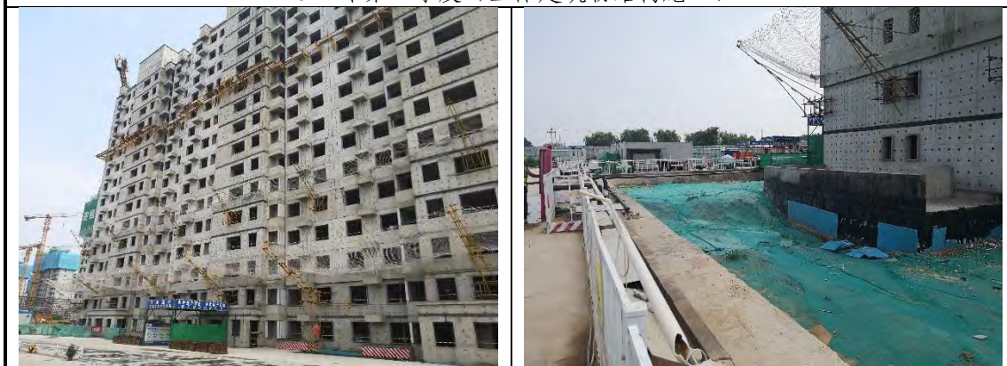
2021 年第二季度（主体建筑物结构施工、肥槽回填）
