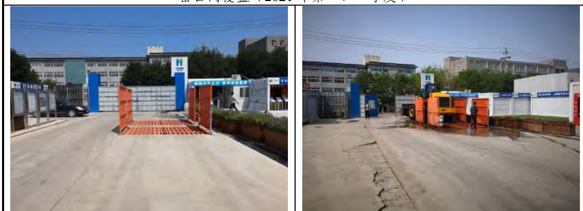
车辆洗车槽及临时沉沙池（2020年第三季度、2021年第一季度）
