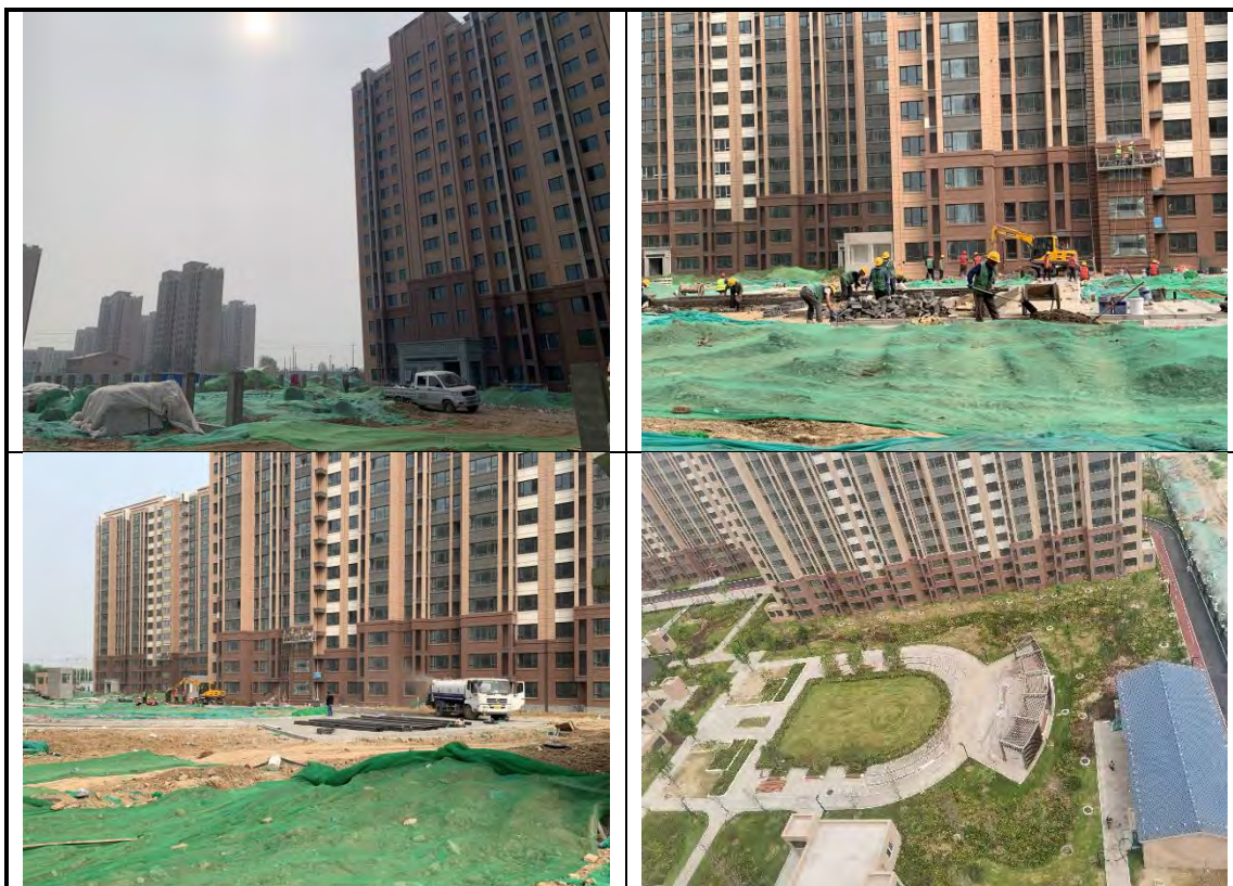
2022 年第二季度（小市政、道路及部分绿化施工）
