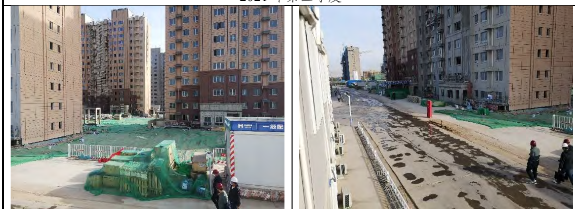
2021 年第四季度（主体建筑物装饰装修施工）
